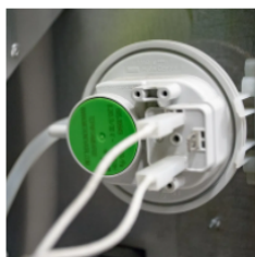
Presostat bezpieczeństwa
